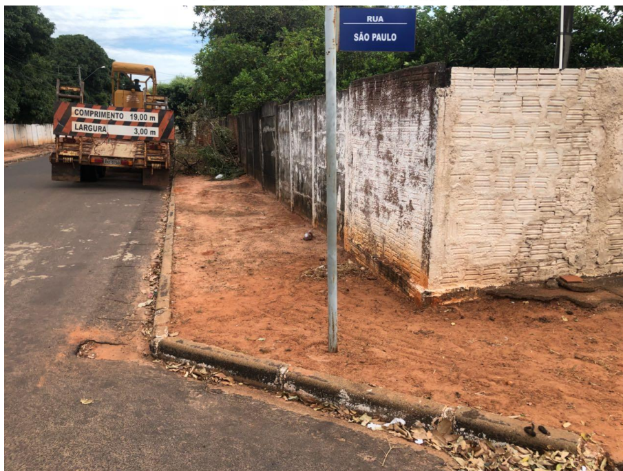
06 – CALÇADA CONFRONTANTE COM RUA BENIGNO EGINO PEREIRA (TRECHO – 03)
