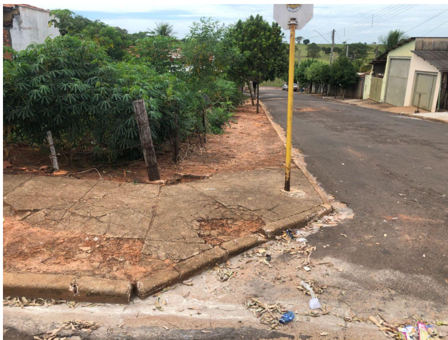
04–CALÇADA CONFRONTANTE COM A RUA BENIGNO EGINO PEREIRA (TRECHO 02)
