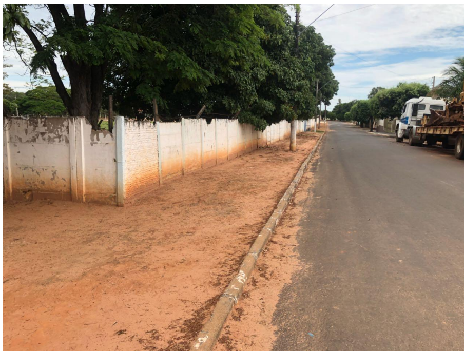
09 – CALÇADA CONFRONTANTE COM RUA BENIGNO EGINO PEREIRA (TRECHO – 05)
