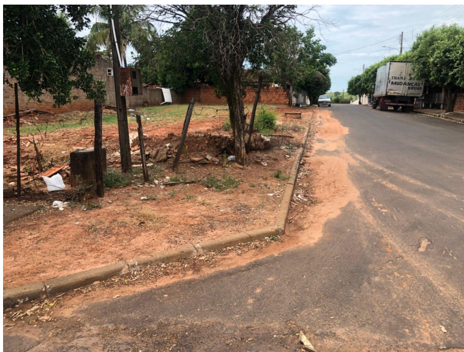
05 – CALÇADA CONFRONTANTE COM RUA BENIGNO EGINO PEREIRA (TRECHO – 03)
